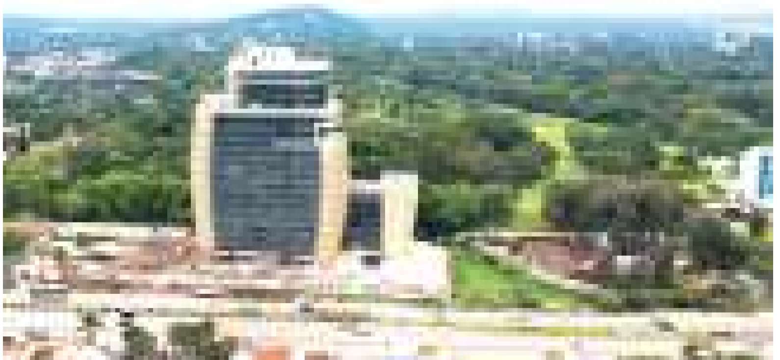
Makao Makuu ya Umoja wa Posta, Barani Afrika (PAPU Towers), Arusha.
